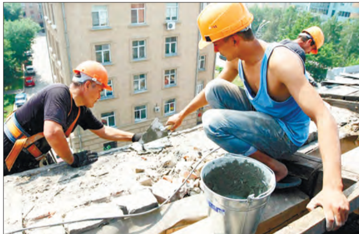
Капитальный ремонт в Ленинградской области делает организация, которая выигрывает соответствующий конкурс
